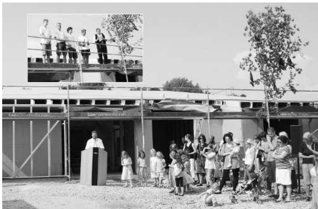
Richtfest sechs Monate nach dem Spatenstich. Foto: ZVW
